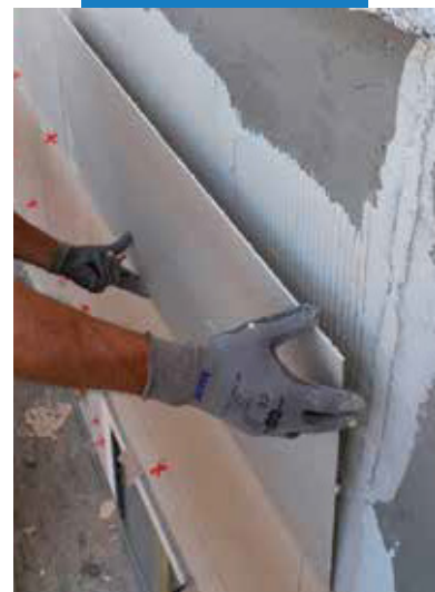
Укладка тонкого керамогранита на фасад
