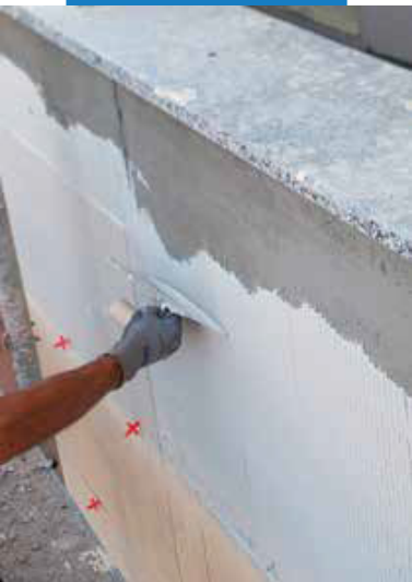
Облицовка фасада: нанесение клея на основание.
