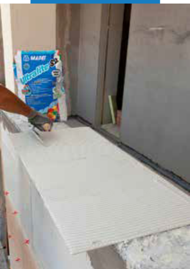
Нанесение клея на тыльную сторону плит
